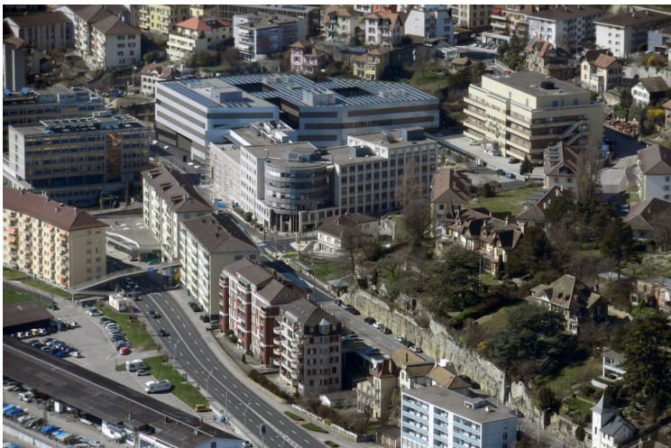
Centrale solaire sur la toiture de Microcity | 1'271 m 2 | 224'500 kWh/an (env. 64 ménages)
