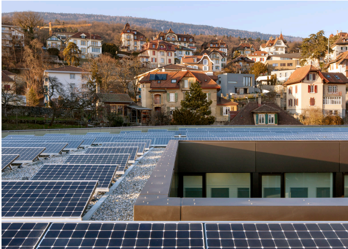
Centrale solaire sur la toiture de Microcity | 1'271 m 2 | 224'500 kWh/an (env. 64 ménages)
