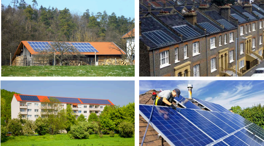
Enjeux esthétiques et problèmes d'efficacité énergétique soulevés par les projets de rénovation sans réelle intégration des éléments PV
