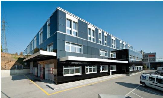
SIE SA, Service intercommunal de l'électricité
