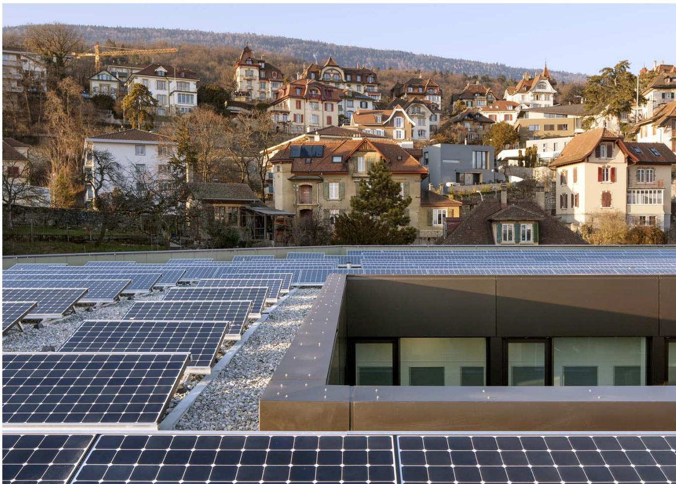
Centrale solaire sur la toiture de Microcity | 1'271 m<sup>2</sup> | 224'500 kWh/an (env. 64 ménages)
